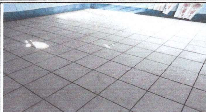
Foto 1: Cambio de piso de cemento por piso cerámico
