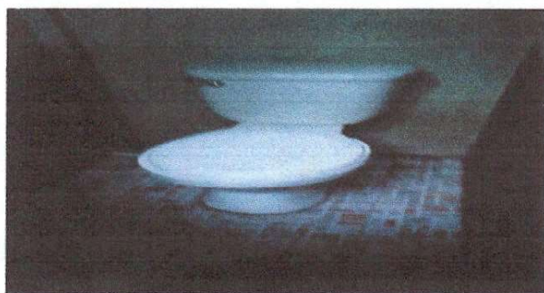
Foto 5: Cambio de hinodoro
