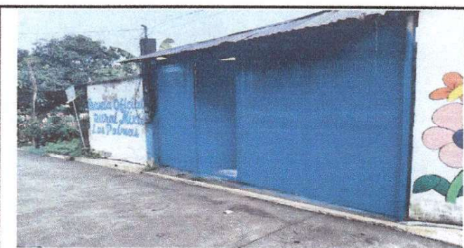
Foto 6: Cambio de portón por estado.
