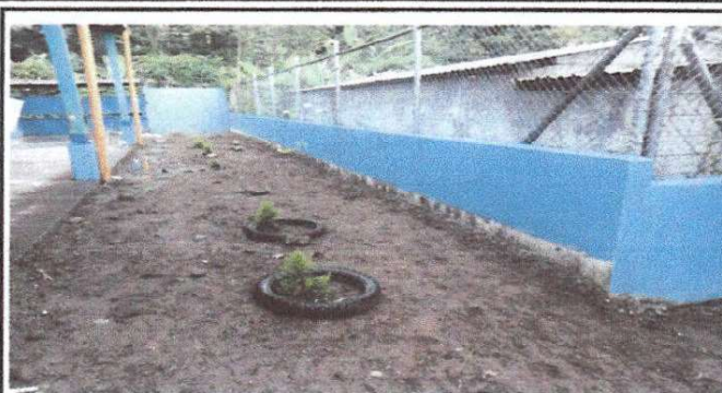
Foto 2: Repello y pintura de pared perimetral
